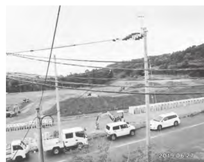
義務教育学校グラウンド新設工事の状況
